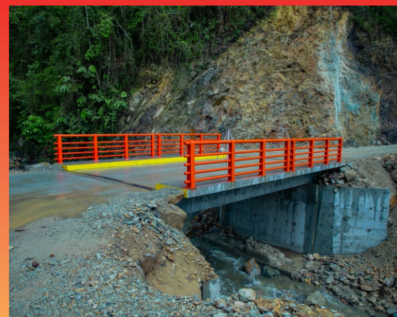
Construcción Puente El Palmo La Cascarilla - Jaén
